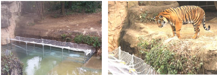
展示場内の転落防止ネット
