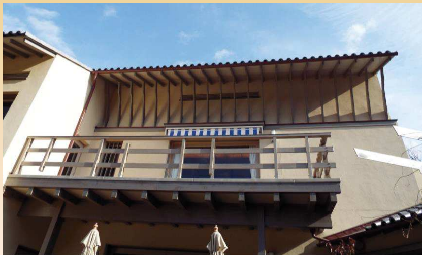
▲垂木と同じ数の頬杖が並ぶ形でベランダの上の屋根庇を支えています。垂木や梁の多数の並びで木材を強調したデザインになっています。
