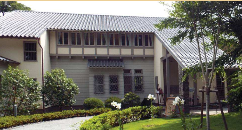
▲2階はハーフティンバー、その下は下見板張り、左右はリシン掻き落としの広い壁という作りのバリエーション
