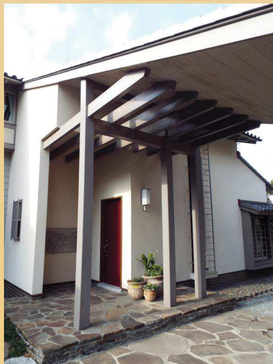
▲複数の梁を露出させて長い屋根から続く車寄せの庇を支えると共に玄関の意匠を作っています。
