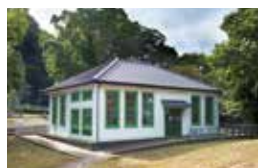
旧細菌検査室 (横浜市長浜ホール提供)
