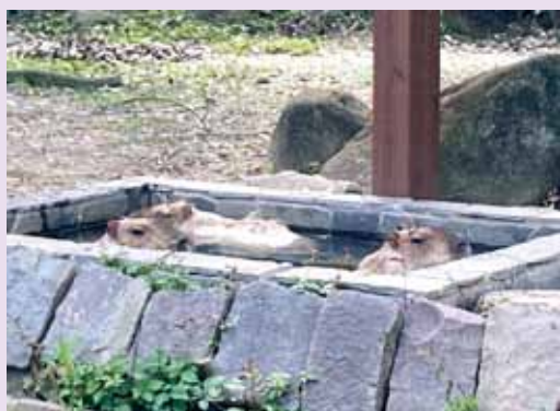
カピバラ展示場の老朽化したプールを更新
