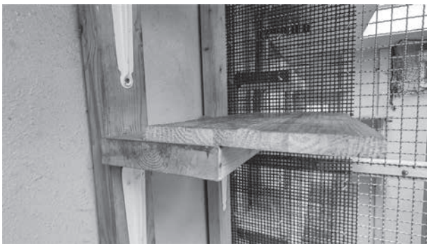
図17 改良して幅広くした足場
