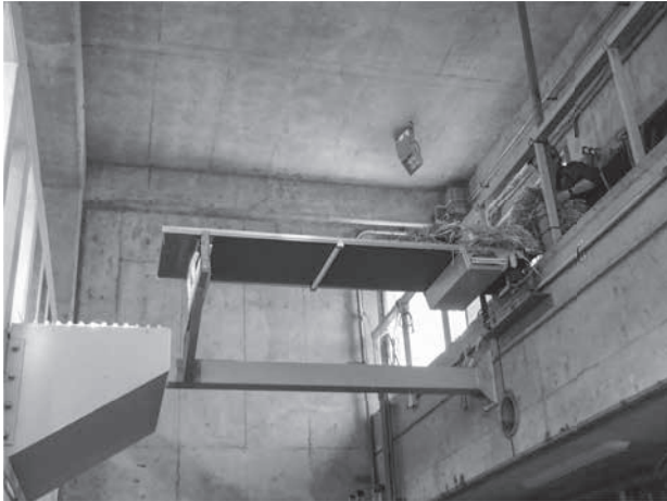
図3 ベルトコンベアの設置
