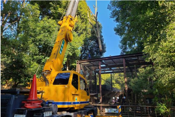
止まり木・支柱の交換工事中のシシオザル展示場
