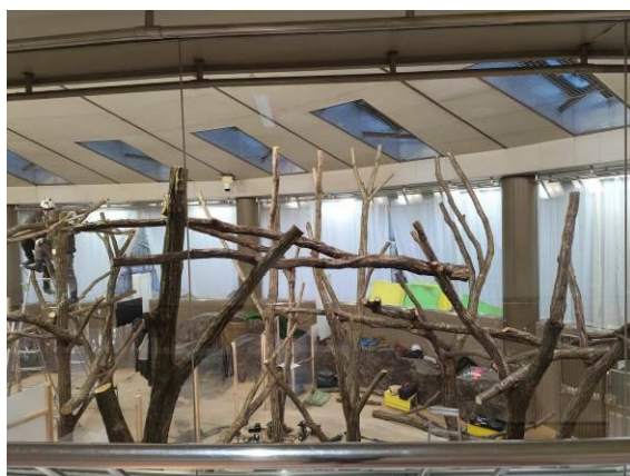
コアラ展示場の止まり木交換止まり木交換 (写真は工事中の様子)
