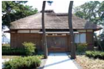
玄関正面 新築復元された台所棟玄関
