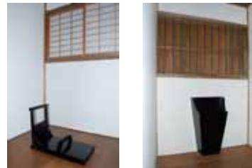
客用便所 本漆仕上の木製大便器・小便器
